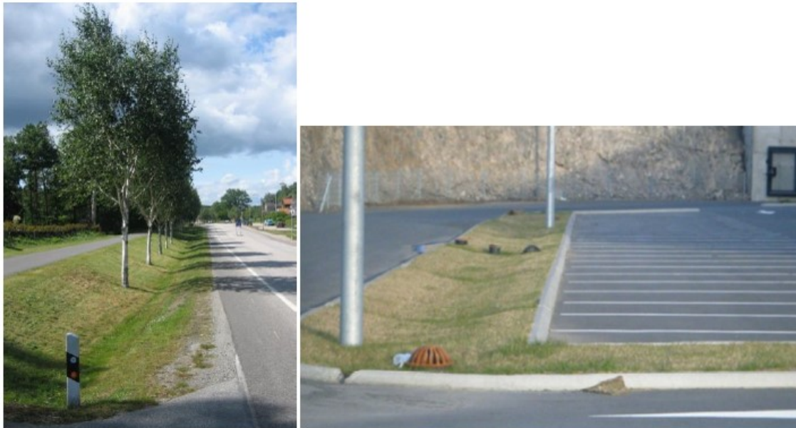
Figur 19 Svackdiken. Till höger svackdike med stensatt kant och kupulbrunn
